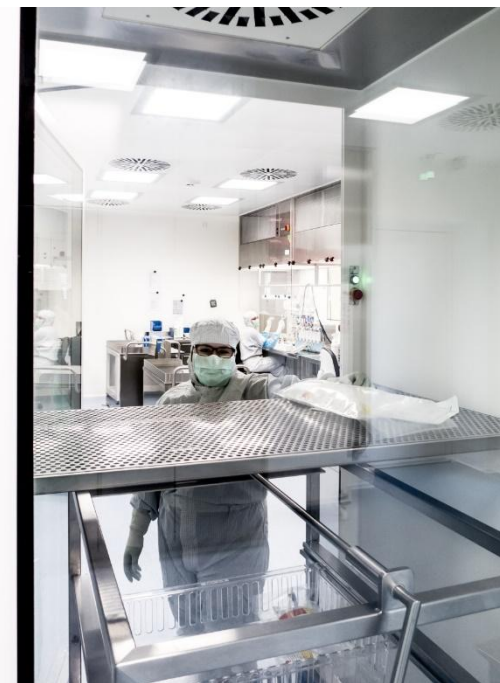
Materialschleusen Aseptische Herstellung Apotheke des UK Erlangen
