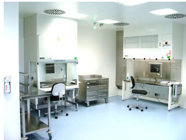
Reinraum Klasse B Zytostatikaherstellung Apotheke des UK Erlangen
