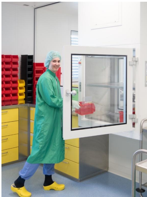
Materialschleusen Aseptische Herstellung Apotheke des UK Erlangen
